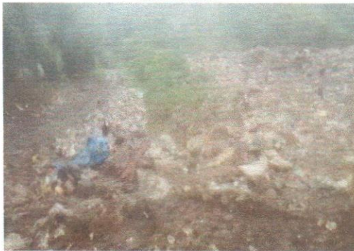
OBRA EN EJECUCIÓN
