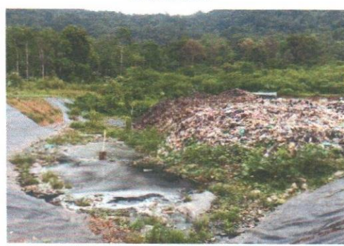
OBRA EN EJECUCIÓN
