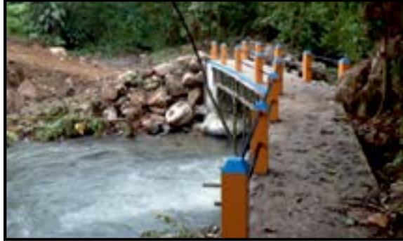
Construcción del Puente Peatonal sobre el Río Chaucha, en la Comunidad Hermano Miguel.
