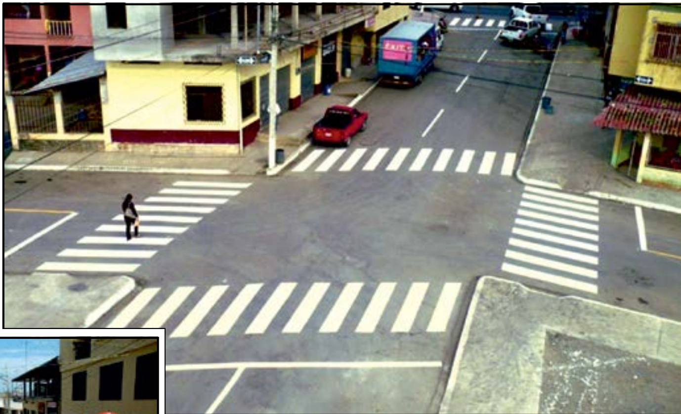
Asfaltado de las calles Av. Río Siete y 28 de Marzo
