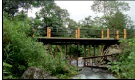
Construcción del Puente Peatonal sobre el Estero Milagros, en la Comunidad Salavina
