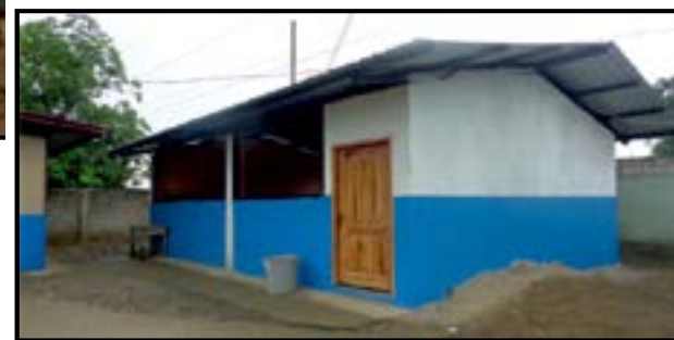
▲ Mejoramiento de Aulas
