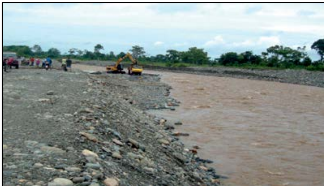
Mejoramiento, ampliación y mantenimiento del muro de gaviones en la comunidad de Shumiral.
