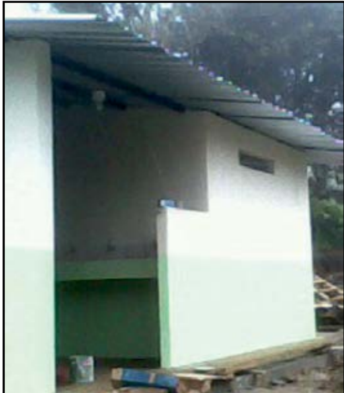
Construcción de Baterías Sanitarias, Comunidad Limón
