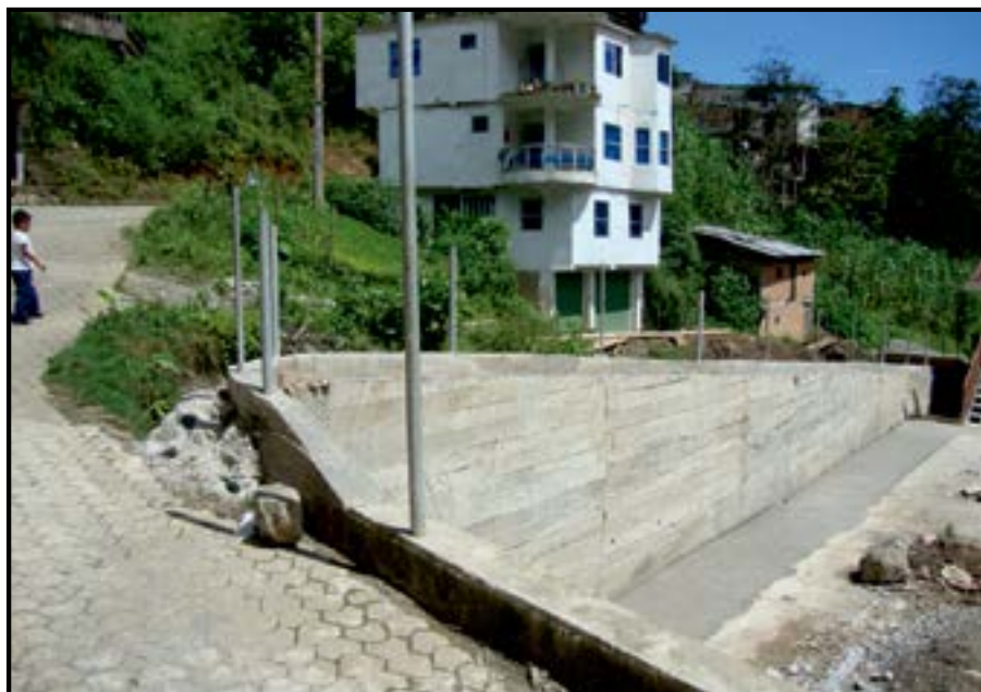
Muro de Contención de la Escuela 16 de Julio, de El Carmen de Pijilí
