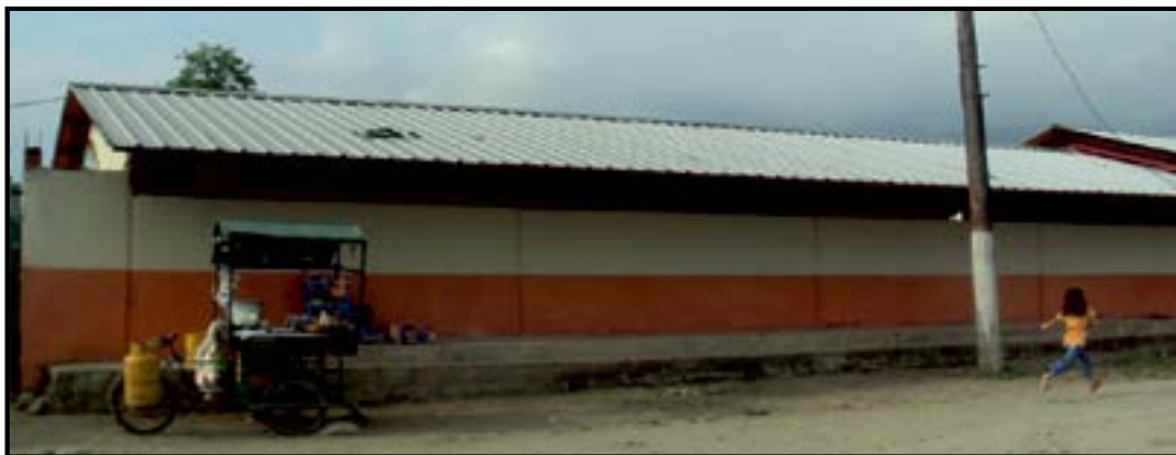
Cerramiento de la Escuela
