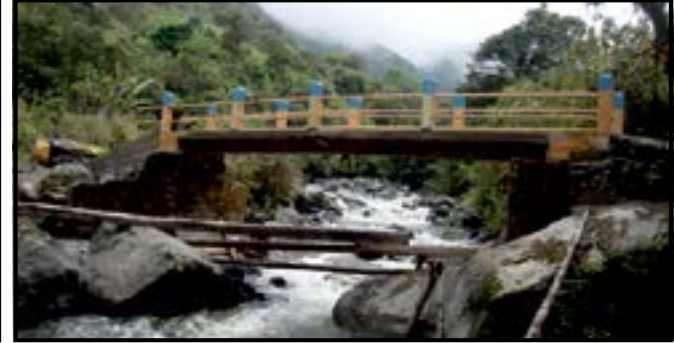
Construcción del Puente Peatonal sobre el Río Aurines, Comunidad Pijilí Chico
