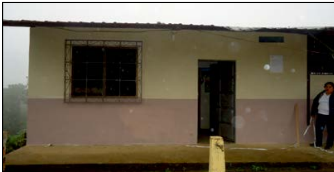
Construcción de Vivienda para Maestra de la Escuela Progreso Campesino, en la Comunidad "Trinchera Campesina"
