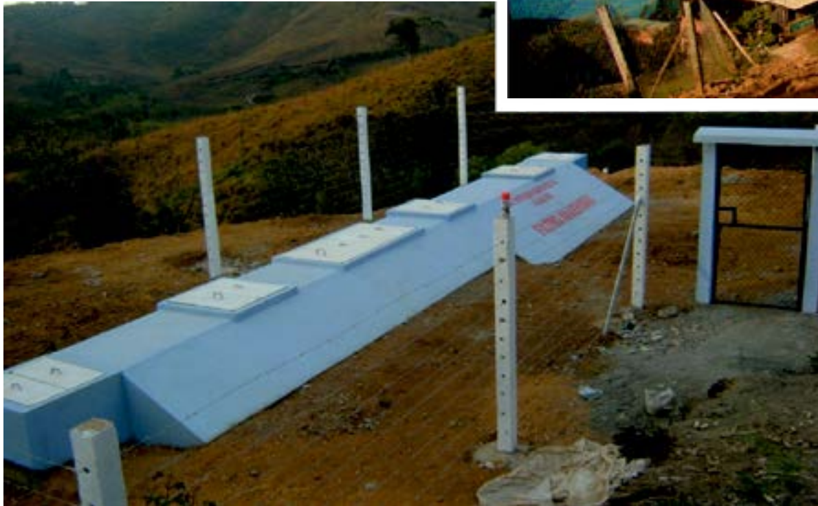
Filtro Anaerobio (obra entregada en el año 2010).
