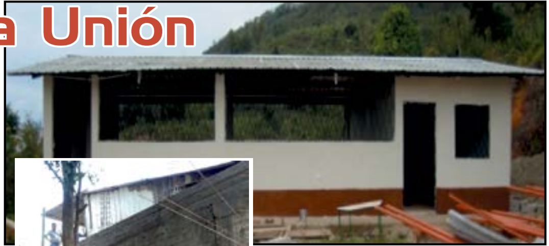
Construcción de Aula Escolar
