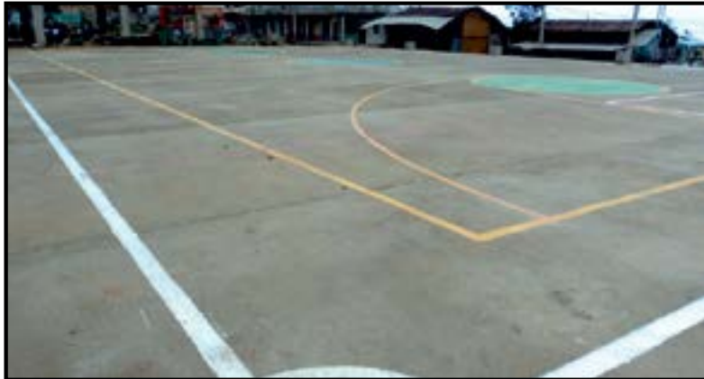
Cancha múltiple, con arcos y debidamente señalizada
