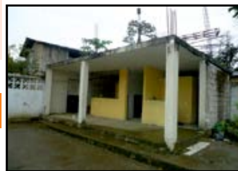
Construcción de Batería Sanitaria
