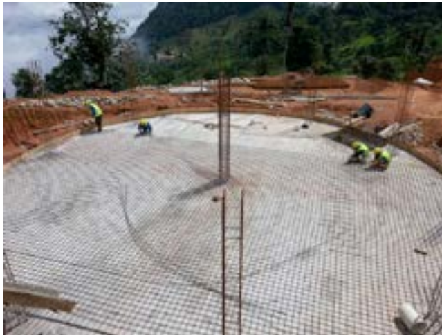
Tanque de Reserva principal del Sistema Regional de Agua Potable, con una capacidad de 500 m 3
