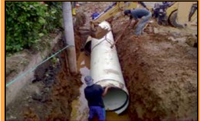
Construcción del alcantarillado para aguas lluvias en la calle 24 de enero (Aguas del Chorro)
