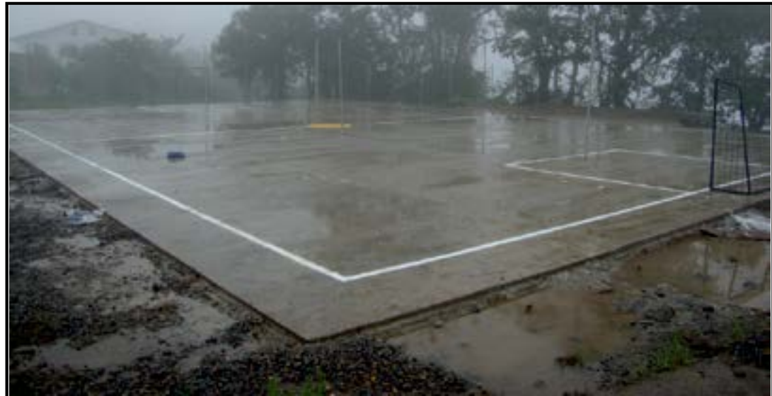
Construcción de Cancha en Pahuancay
