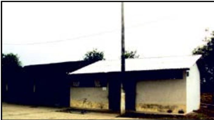
Construcción de Aula de Cómputo
