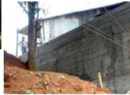
Muro de Contención de la Escuela La Unión
