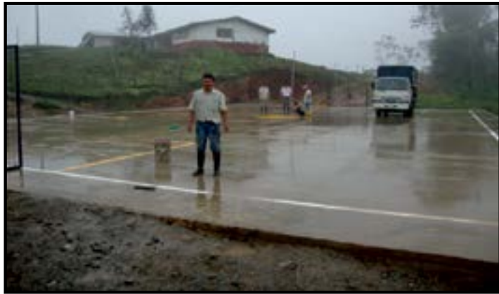
Construcción de Cancha. Comunidad Santa Teresa
