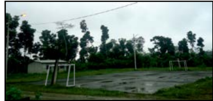
Mejoramiento de Cancha e iluminación.
