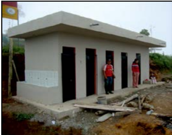
Batería Sanitaria Comunidad Santa Teresa
