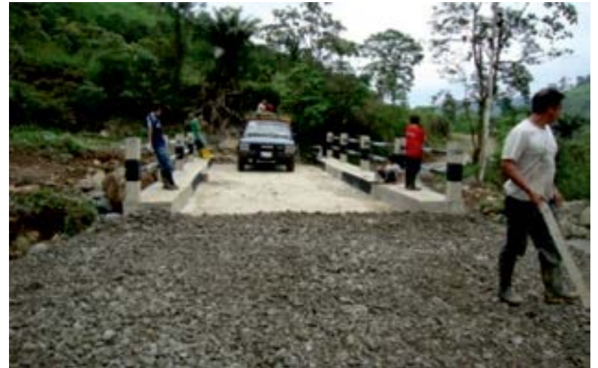
Apoyo con materiales pétreos, en la construcción del puente Carrozable, sobre el río Cachi, vía San Jacinto de Iñán - Progreso.
