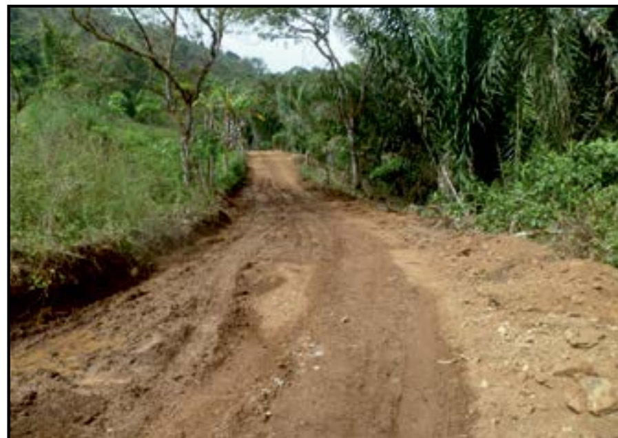
Apertura de Vía a la Comunidad El Limón
