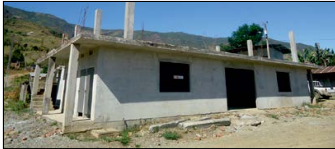
Construcción de la Casa Comunal
