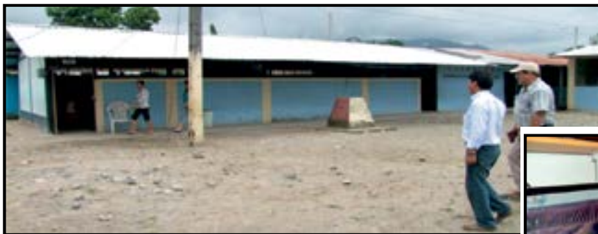
Construcción de Comedor Escolar
