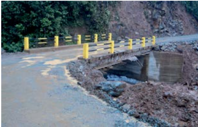
Apoyo con materiales pétreos, en la construcción del puente Carrozable, sobre el río Cachi, en la vía Progreso - Naranjillas.
