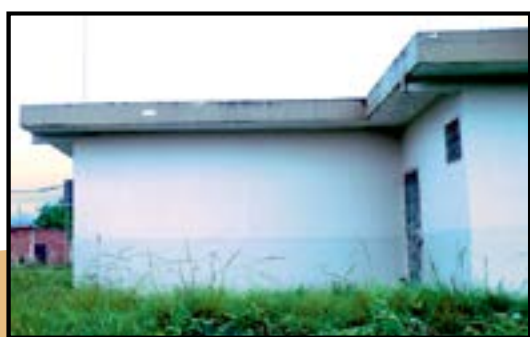
Construcción de la Sala de Emergencias en el Subcentro de Salud
