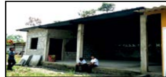
Construcción de Comedor Escolar
