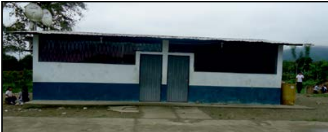
Construcción de Aula de Cómputo
