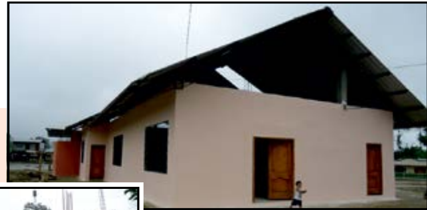
Construcción de la Casa Comunal
