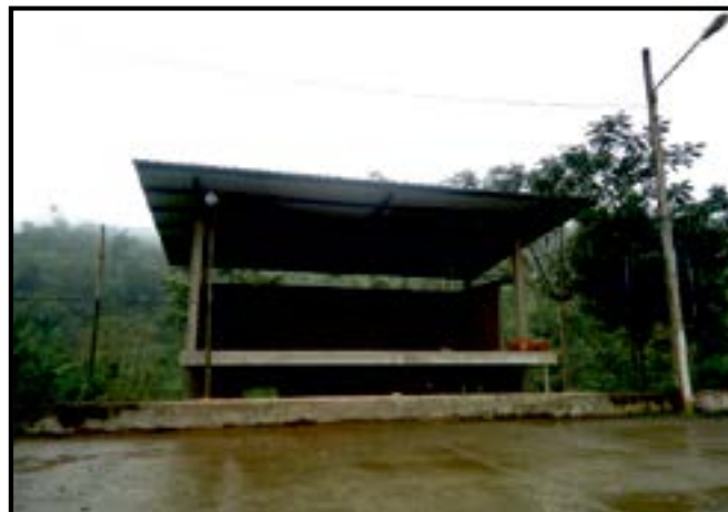
Construcción de Escenario e Iluminación de Cancha
