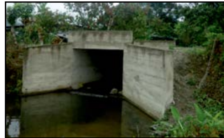
Construcción de alcantarilla tipo Cajón
