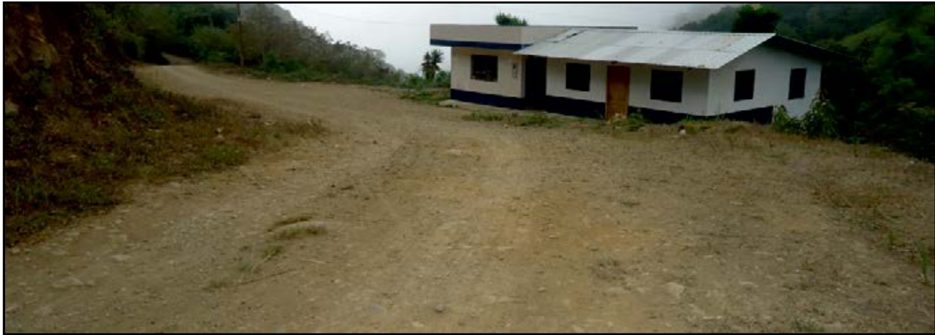
Construcción del Retén Policial; y, apertura y lastrado de la vía alterna "Y" de San José, Centro de Pijilí
