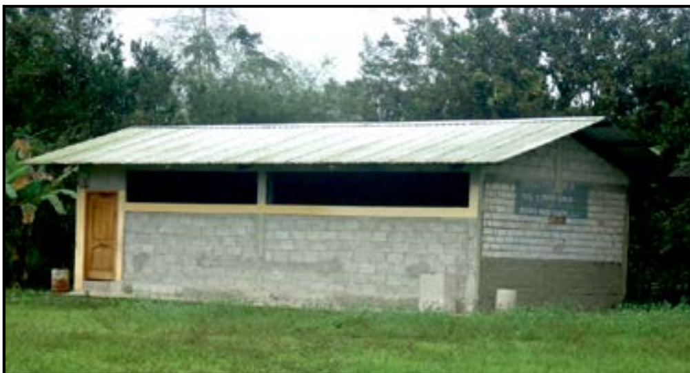
Construcción de Aula de Cómputo con su respectivo equipamiento
